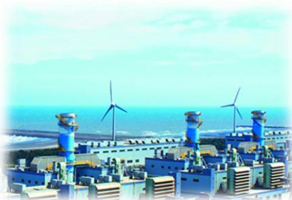
大潭發天然氣電廠
