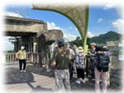
921 大地震車籠埔斷層切 穿石岡壩體，破壞處保存 為國家震災景觀紀念地
